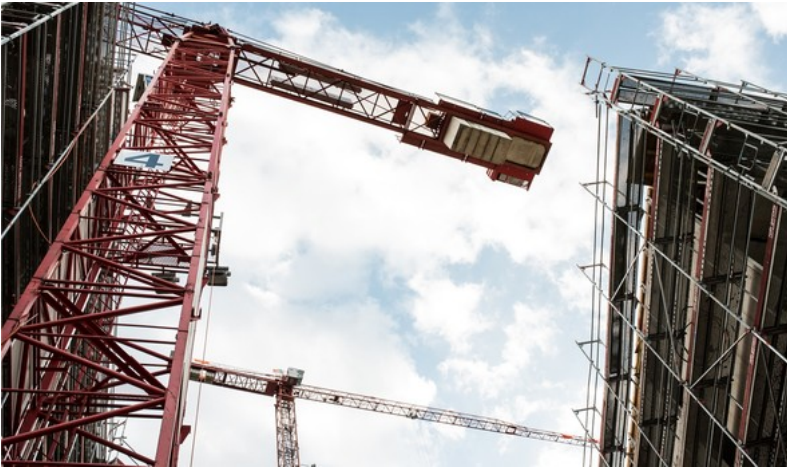
Der Dietiker Limmattower im Bau: Er ist das Symbol einer Region, die wächst und wächst.
