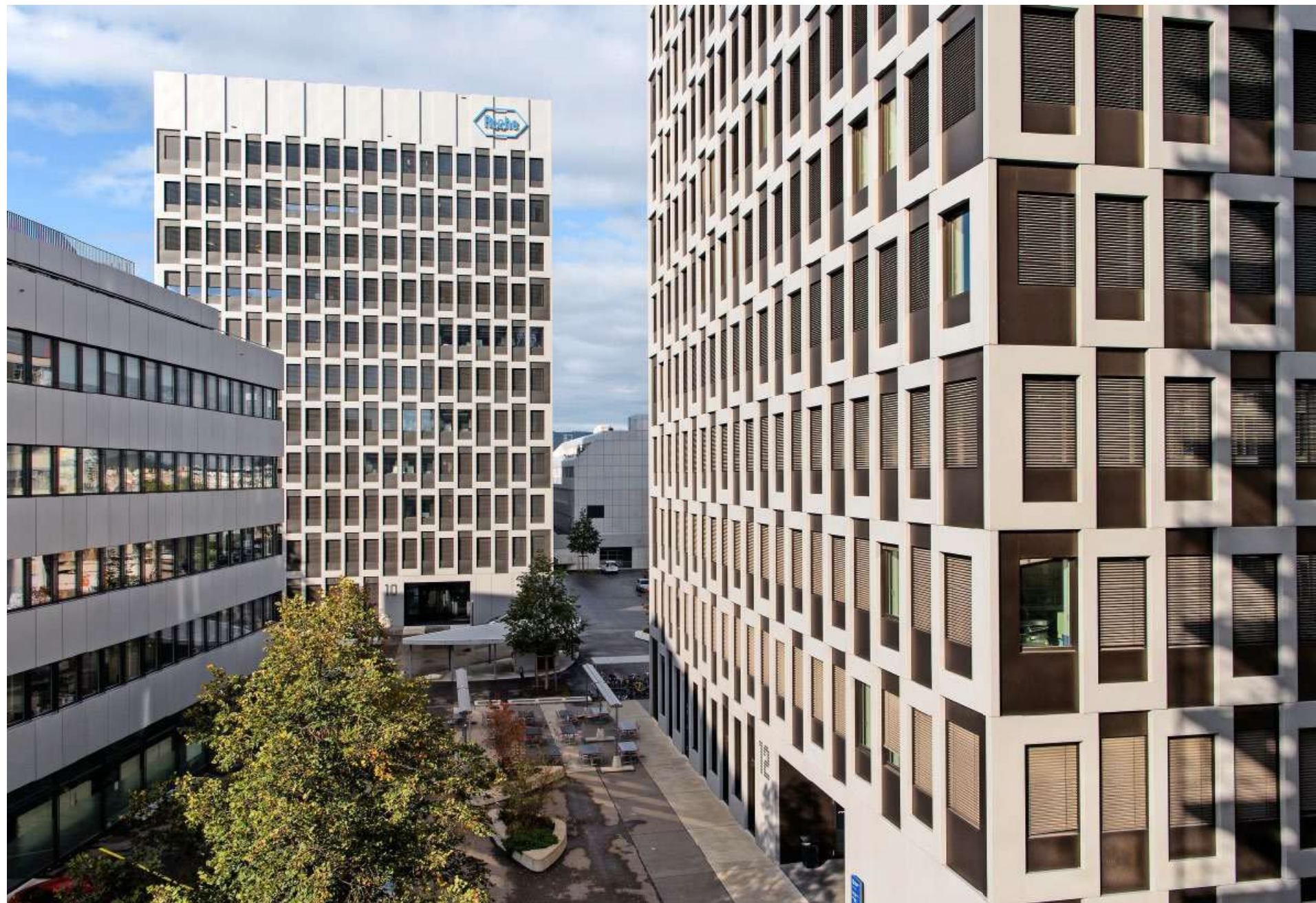
Der Bio-Technopark verzeichnet eine grosse Nachfrage nach Raum. Um sie zu befriedigen, wurden bereits zwei Hochhäuser erstellt. Ein drittes befindet sich im Bau. BILDER: IRIS C. RITTER
